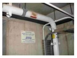
Трубы покрытые в 1995 году с Abcite 1060, VanOs-Duracoat для AWW, по-прежнему на месте, несмотря на высокую конденсацию/давление воды, не показывая ухудшение покрытия с тех пор (почти 17 лет эксплуатации). «Для примера» Эпоксидное покрытие, Макс. 7 лет.
