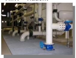
ТМVW водный завод в Зелзате: в 1996 году, Abcite® изнутри и снаружи изогнутой трубы, по-прежнему на месте, без обслуживания.
